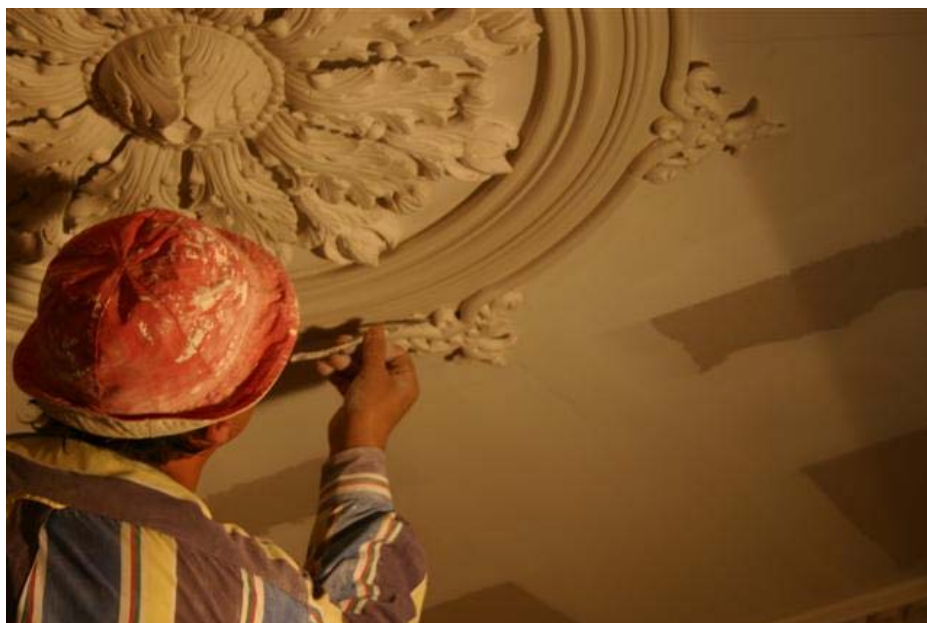
Trabalho de Remate de Estuque num Tecto de Habitação Casa Particular Campo Ourique (Lisboa)
