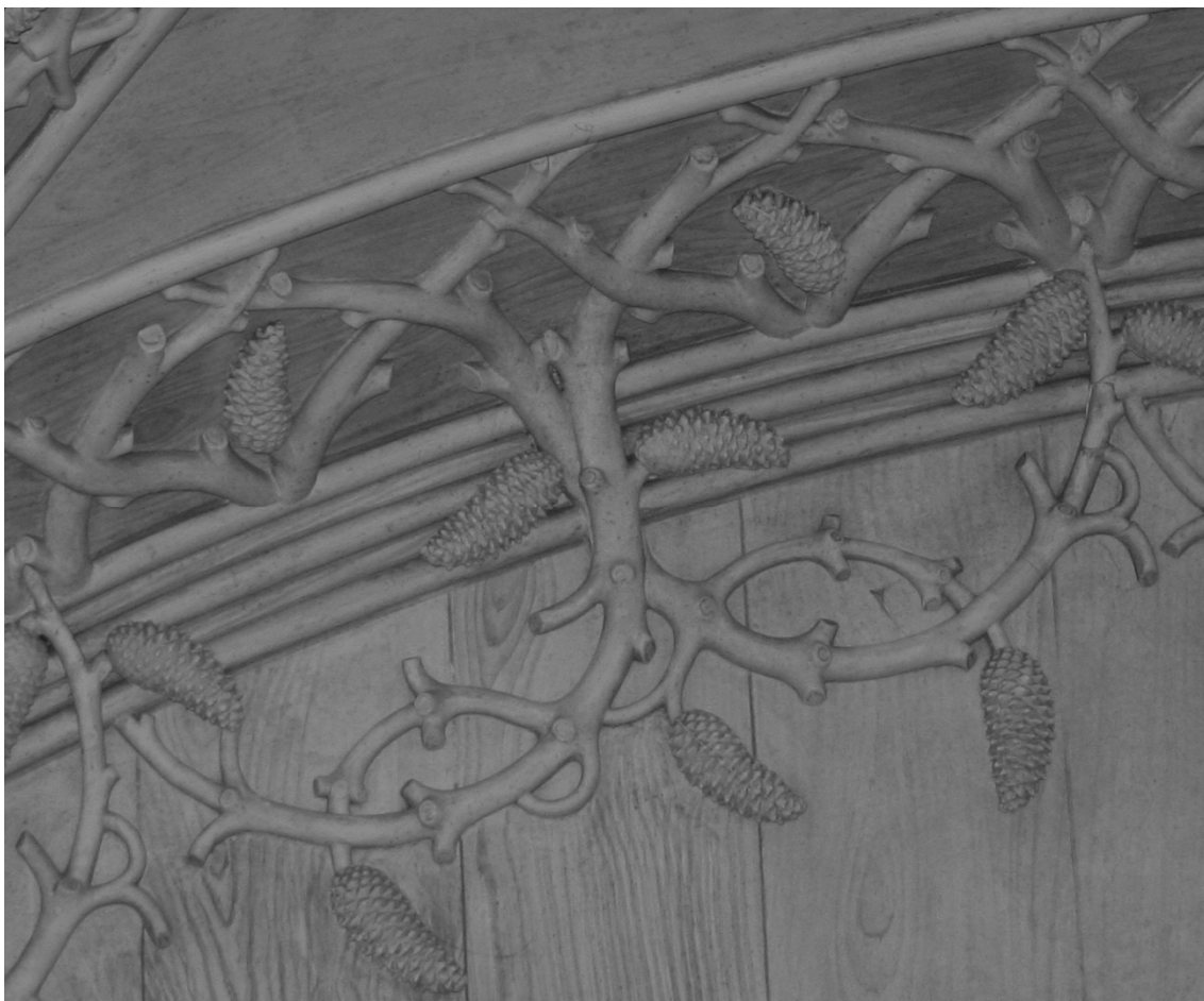
Sanca de Gesso adornada com Ornamento Modelado pela nossa Firma
