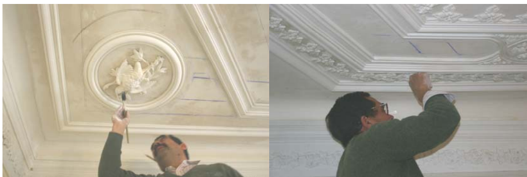
Sequência de Restauro de um tecto estuque trabalhado numa residência particular à Rua de São Bento
